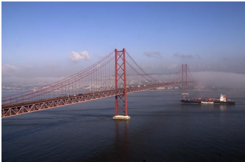
Figure 7: The 25 de Abril Bridge.
